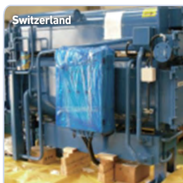
Zentralwascherei HWR-L 50usRT(176kW)
