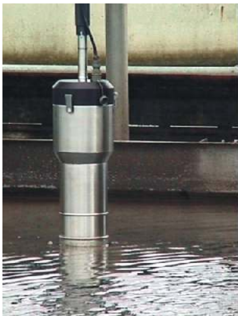
Montáž sondy priamo do odpadovej vody
