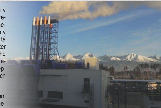
Absorbčné chladiče 2 x 3 MW
